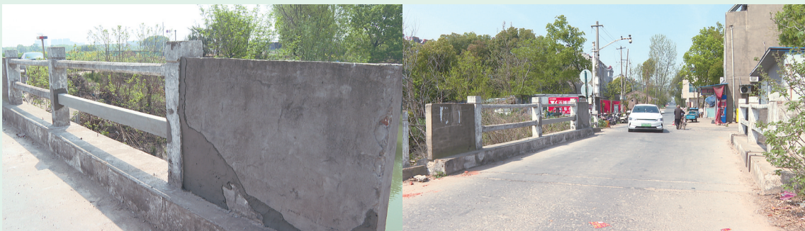
栏杆修复到位,裂缝处也进行了整改。
