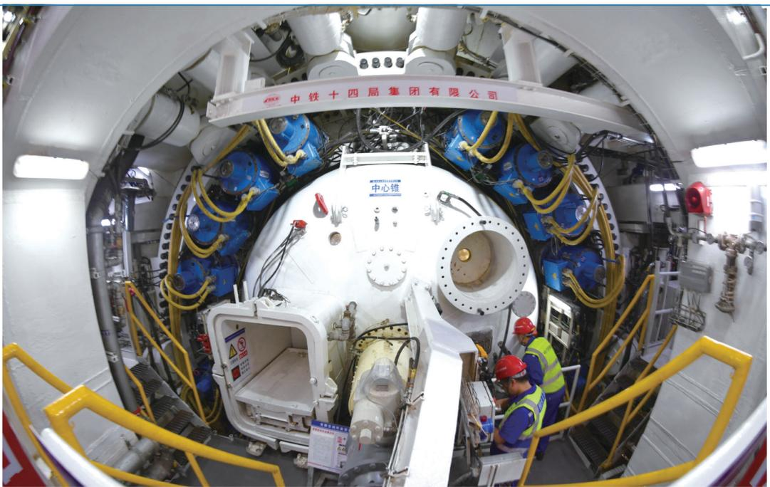
5月9日,中铁十四局技术人员在“启航号”盾构机内巡查。当日,由济南城市建设集团投资建设、中铁十四局承建的济南航天大道穿黄隧道工程南线“启航号”盾构机顺利始发,开挖直径达15.06米。济南航天大道穿黄隧道是规划中济南遥墙国际机场与济南新旧动能转换起步区之间的重要通道,全长3888米,采用双向6车道城市主干路技术标准,设计时速60公里,其中盾构段长3252米。(新华社发)
