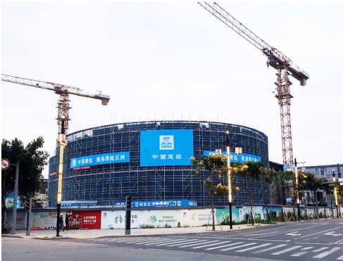
由中国建筑五局承建的苍南大剧院项目顺利建设中,项目位于春晖路。 2022年10月10日摄
