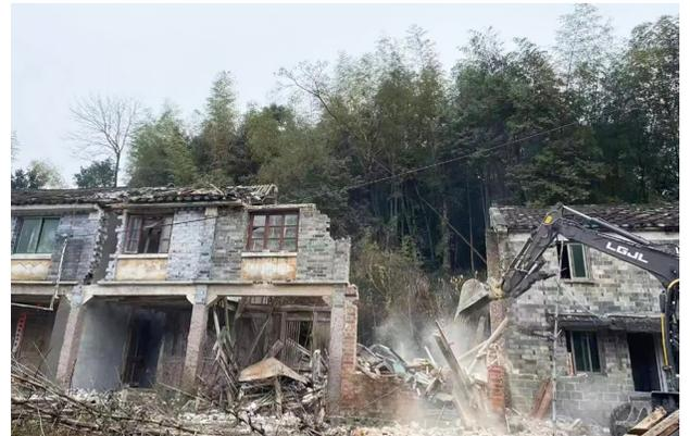
@灵宣: @今日苍南 前日,灵溪镇组织镇属相关部门、华阳共富委等,拆除华阳碗窑美村114-116号一幢3间D级危房,及时消除安全隐患。本次行动涉及的危房,为多年前建成的老旧砖木结构房屋,经有资质的专业机构评估鉴定为D级危房,多数承重构件严重破坏,承重结构承载力已不能满足正常使用要求。
