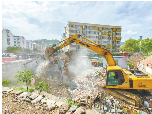
⑥灵宣:⑦今日苍南 日前,灵溪镇依法拆除渔塘口(江湾南大桥旁)的4间违章建筑,提升县城环境质量,助推民生工程。据了解,该4间房屋未取得合法手续,属于违章建筑。拆除后,将根据鳌江南港流域江西垟平原排涝工程推进安排,利用拆违腾退的土地和空间,提高排涝能力,缓解汛期主城区内涝问题。
