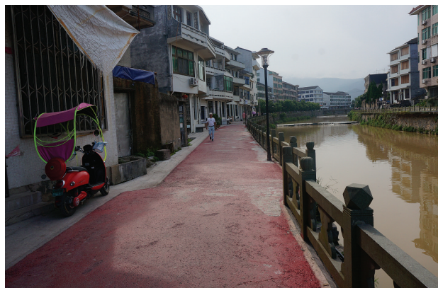
◎邱新福:◎苍南新闻网 近日,矾山镇对矾山溪滨溪桥至下桥沿岸两侧进行改造,在原有道路基础上建设彩色步道,增添景观,更方便散步骑行,受到群众好评。
