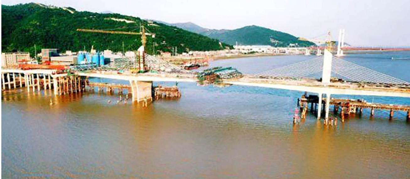
本报讯(龙发)近日,鳌江五桥项目最后一榀T梁安装完成,标志着鳌江五桥全桥施工进入最后冲刺阶段。据悉,鳌江五桥各项工序正按计划紧张有序推进,预计将于12月31日前完成全桥贯通目标任务。
