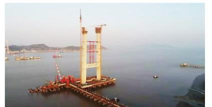
瓯江北口大桥建设已进入平稳期,大桥最难的建设点——中塔沉井于11月顺利封底,为下一步水中承台建设、中塔塔身拔高等常规项目施工铺平道路,目前中塔水中承台已经开始建设,完成之后塔身将开始拔高,大桥北塔、北塔锚碇已完成,南塔塔柱施工已完成。
