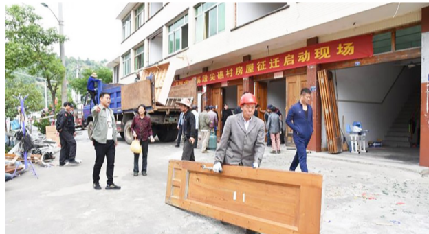
④卢孔祥: @今日苍南 前日,赤溪镇再次开展228国道赤溪尖礁段房屋征迁拆除工作。本次征迁房屋位于尖礁环海公路旁,共计15间。经过前期工作,征迁户积极配合,主动搬移屋内各类生活物品。据悉,中墩社区尖礁段涉及征用共74间房屋,前期已拆除9间。下一步,该镇将继续有序开展征迁拆除工作,全力配合推进228国道建设。
