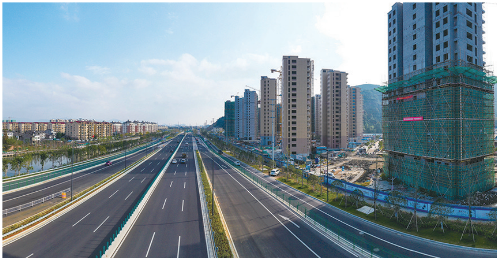
黄岩经开区道路建设现场。
