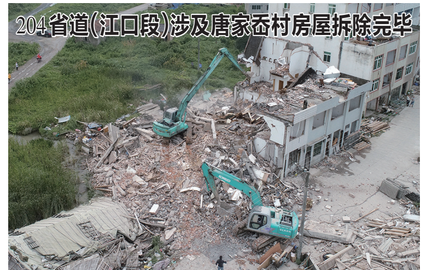
204省道(江口段)涉及唐家岙村房屋拆除完毕
