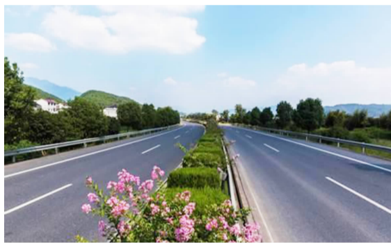
建德县道杨梅公路
