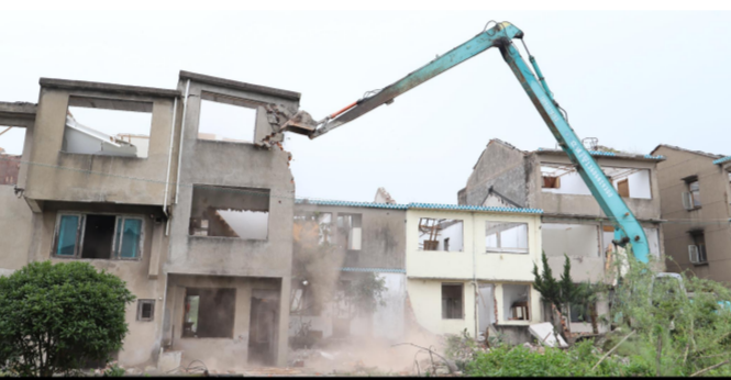
图为葭沚上马前大村拆迁现场
