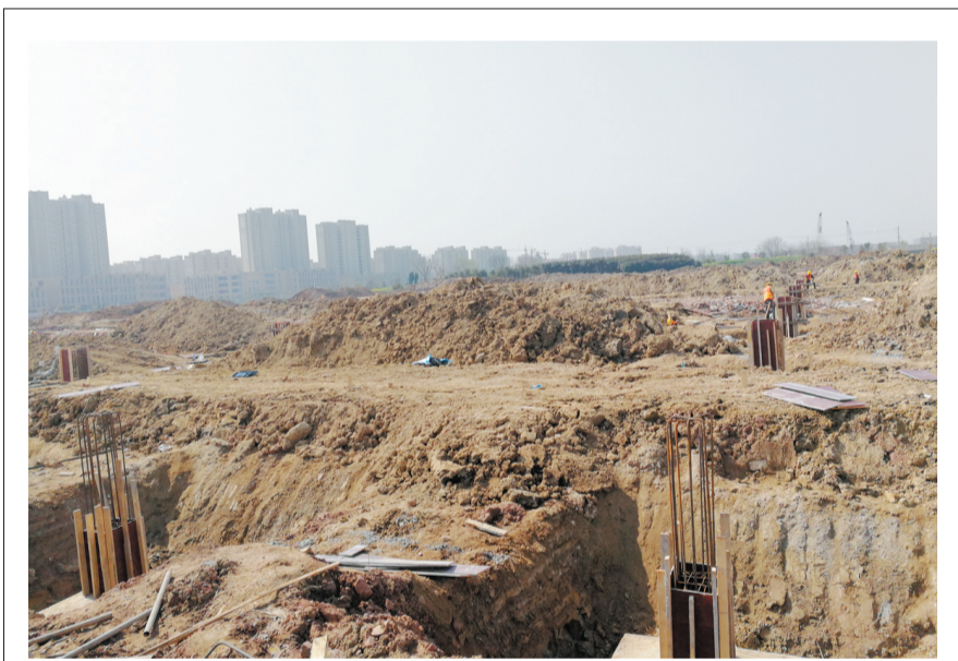
连日来，位于郭庄空港新城的DHL之路得跨境电子商务产业园正在抢抓晴好天气进行一期施工。据了解，该项目总占地490亩，总投资15亿元，注册资本2990万美元，主要从事电子商务、货物存储配送、区域中转(分拨)和交易结算等业务。一期占地200亩，新建8.5万平方米自动化仓储用房，年储存普通货物60万吨，预计今年12月竣工。图为施工现场。
