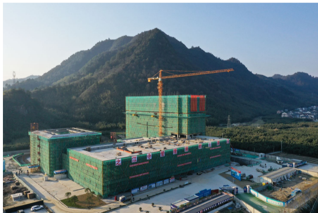
於潜人民医院整体迁建主体工程结顶
