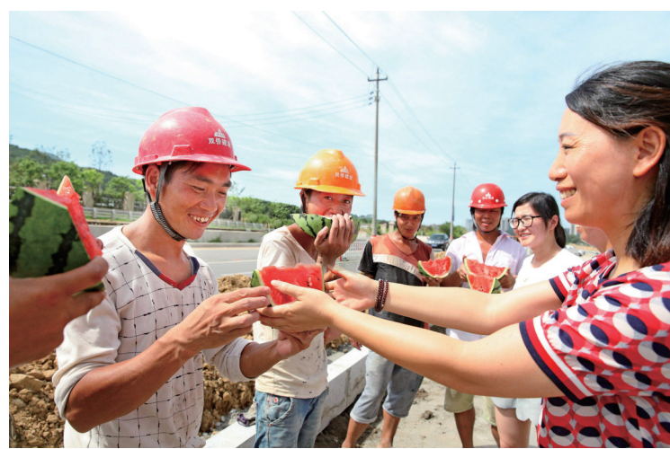
昨日上午,湖东社区工作人员带着西瓜、毛巾、防暑药品等来到兴海北路提升改造工程工地,慰问奋战在高温一线的工人们。兴海北路提升改造工程是县重点实事工程之一,为确保工程的进度和质量,施工人员头顶烈日,冒着高温坚守在工地上,为我县的城市道路建设作出了贡献。(记者 李江林 通讯员 吕咪咪 摄)
