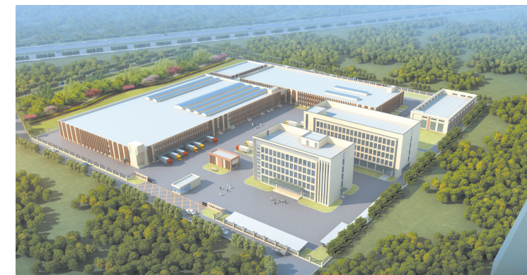
国资国企成为改善民生的主力军。图为在建的宁海县中心屠宰场迁建(一期)工程。
