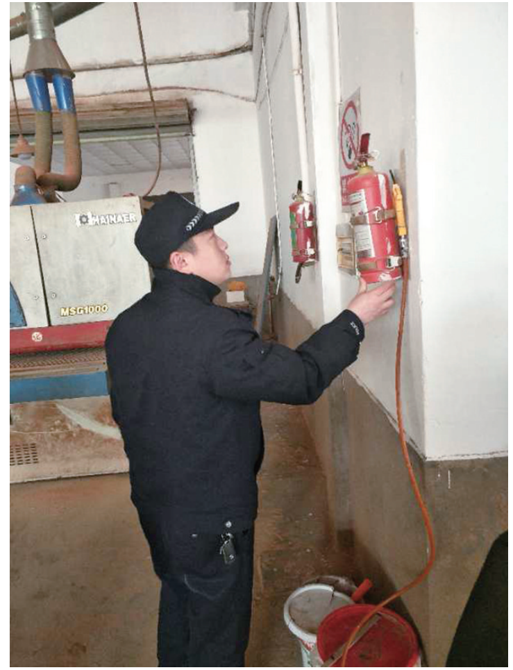
民警检查企业消防设备完好情况
