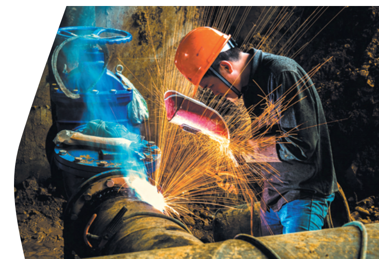
供水管道焊接
