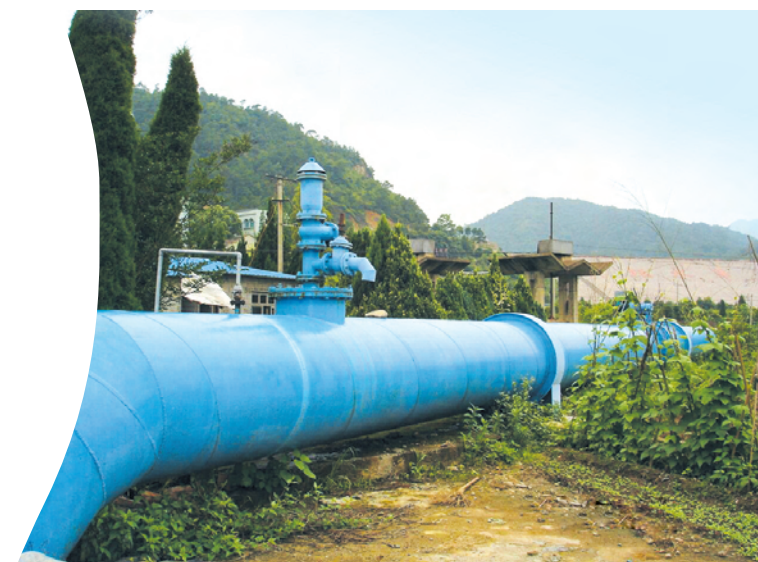
黄坛水库至城区水厂的全封闭引水专管
