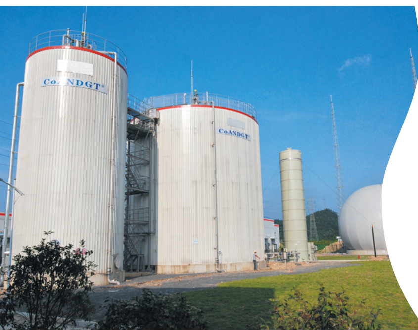
宁海城北污泥处理厂
