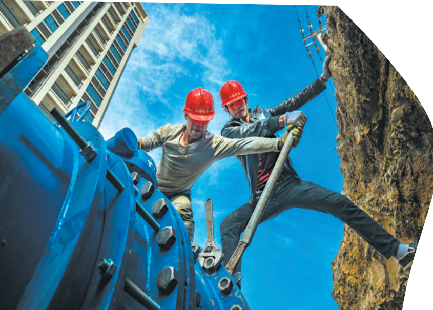
供水管道建设
