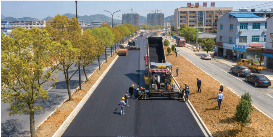
主车道面层沥青浇筑施工(2019年4月)
