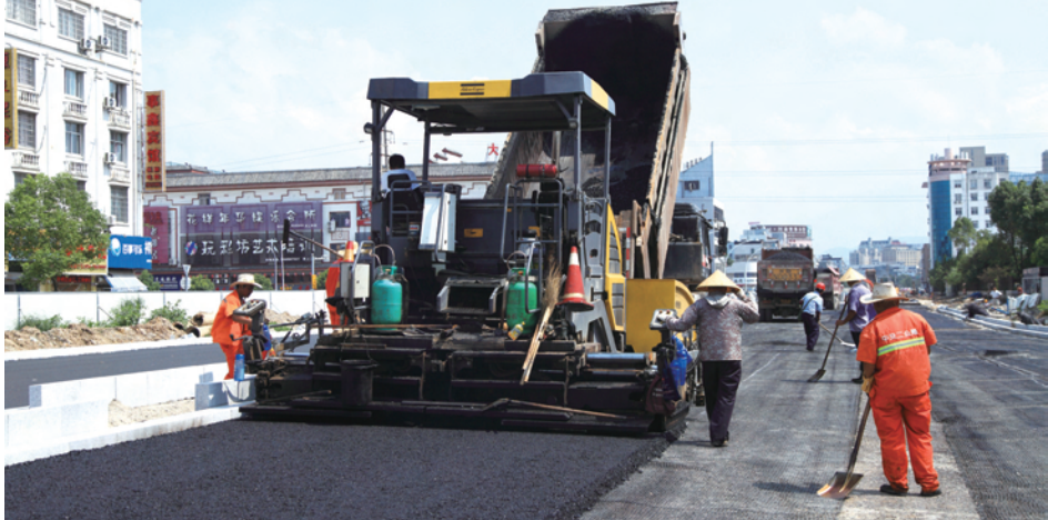
主车道面层沥青浇筑施工(2018年8月)
