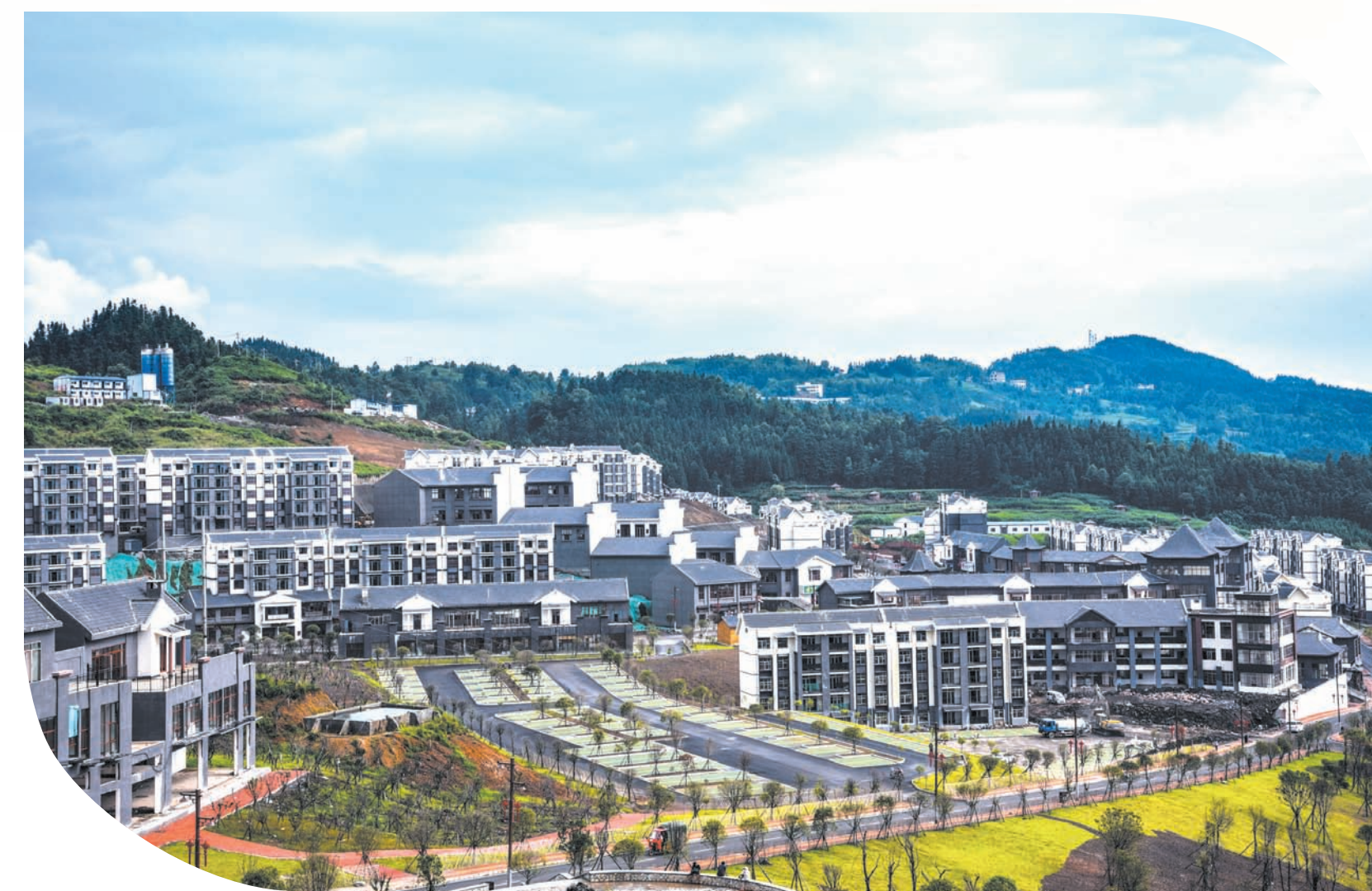
建设中的晴隆县沙子镇美食小镇易地扶贫搬迁安置点
