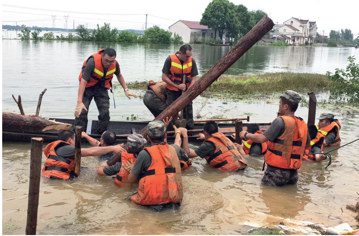
7月28日下午5时30分,养贤乡宝南村圩堤因长时间高水位浸泡,圩堤渗透,突发1处管涌险情。第72集团军某旅合成营150余名官兵刚完成南秋圩3小时加固任务后,立即投入到管涌险情处置当中。经过3个小时的全力奋战,全营150名官兵共扛运沙袋2000余袋,将管涌险情基本排除,及时保护了宝南村村民的生命财产安全。汤玉峰 摄
