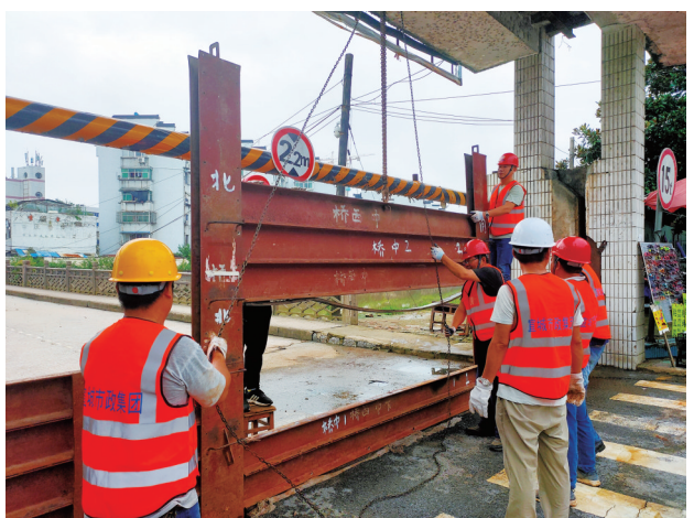
由于现老城区洪水退至安全水位12米以下,考虑到居民通行需要,老城区(敬亭圩)防汛抗旱指挥部研究决定,7月29日上午8时,封闭了20多天的济川桥(老东门大桥)正式解封,恢复正常通行。 吴文婷 摄
