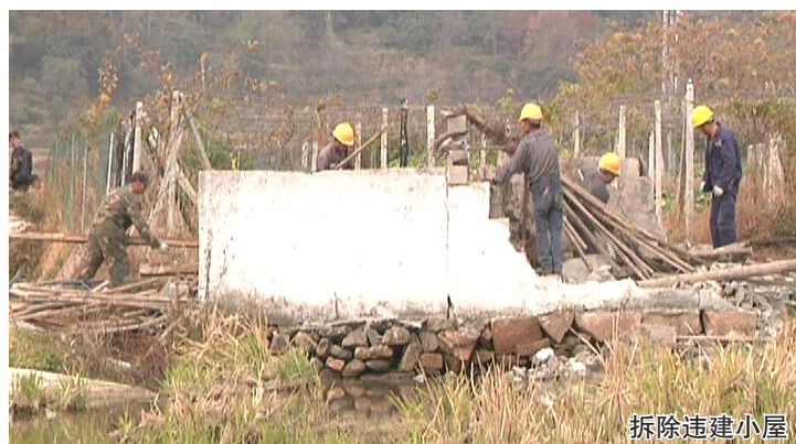
拆除违建小屋
