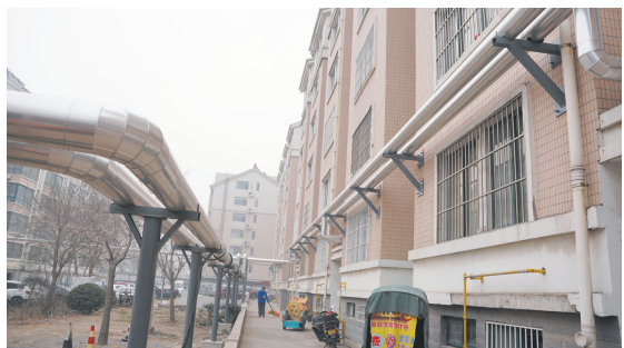
老旧小区二级供热管网改造(香林广场)。
