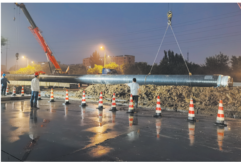
蒸汽管网施工现场。
