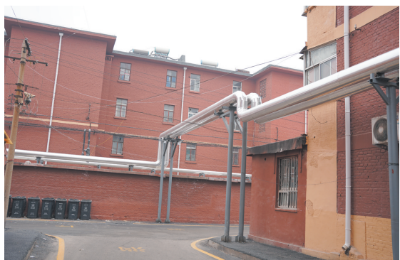
老旧小区二级供热管网改造(宏苑小区)。
