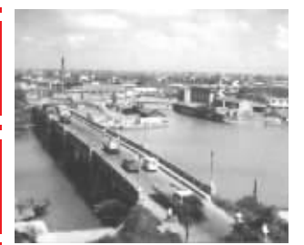
解放后建造的金山大桥
