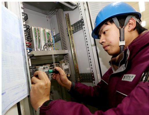
2月25日,施工人员在万安变电站保护屏内按照图纸校验继电接线。220千伏万安变电站承担着我区西北部地区所有用户的电源供给。本次改造把老旧的电磁型继电器改换成先进的微机型继电器,大幅提升电气设备保护回路的科技水平,进一步提升用户用电可靠性。
