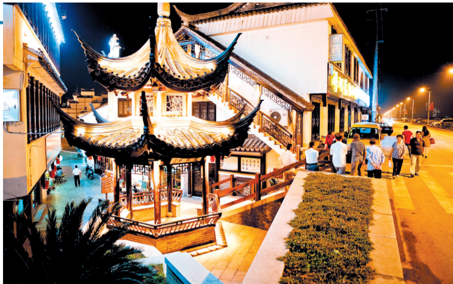
经过一个多月的施工,日前,金山嘴渔村的景观灯光系统试运行状况良好。据悉,渔村的灯光系统主要设置在老街沿街商铺和河道两岸,灯光的设置让晚上的渔村更显古朴魅力。张顺初 摄
