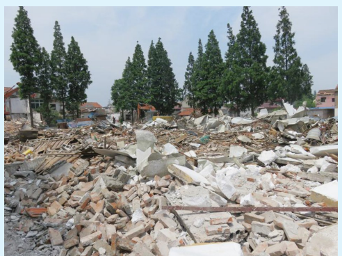
金山卫镇城中村违建拆除前后
