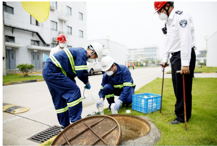
现场排查外排水情况
