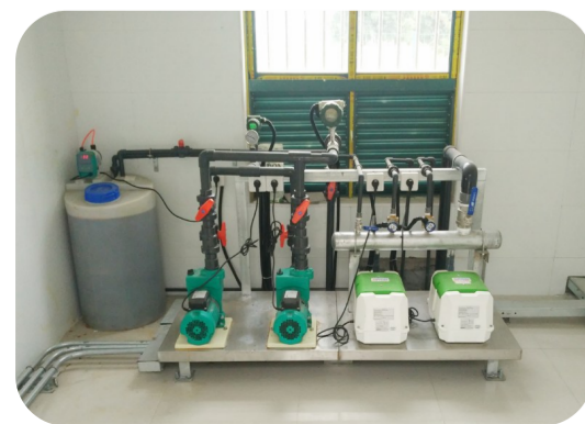
MBR工艺处理站内部
