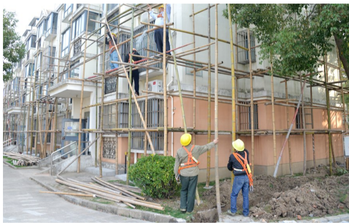
海涯村进行墙面刷新 记者 王佩永 摄
