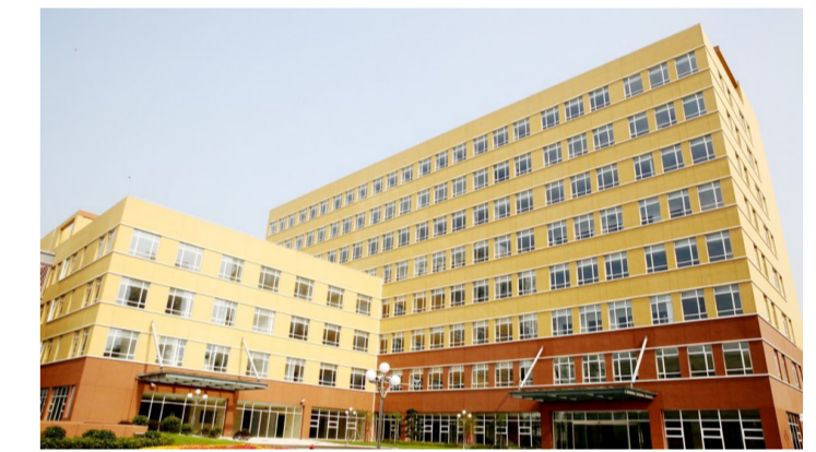
市六院金山分院改扩建二期项目门诊急诊大楼
