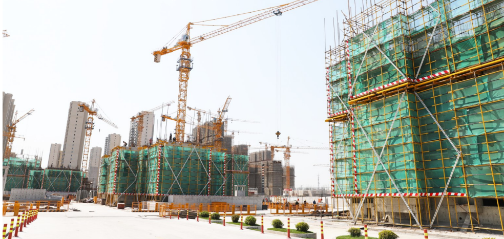
近日,G7、G8两个地块动迁安置房项目都已正式复工。其中,G7地块正在进行主体结构工程,有些房屋的主体结构已到8层,原计划合同工期为2021年8月。目前,G7、G8两个工地的工程进度基本相同,预计比原计划的完工日期延迟约2个月。刘诗寒文/摄
