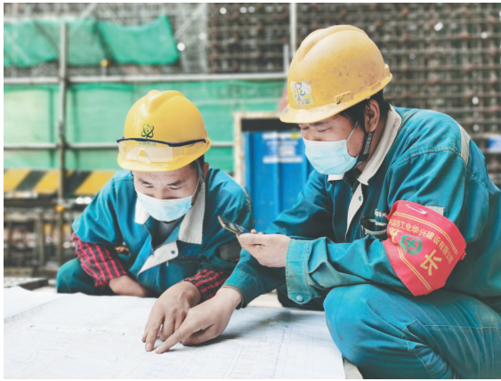
产业工人在现场作业
