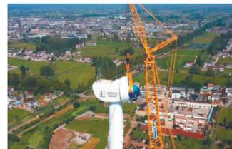
今年9月30日22:00,装机容量3兆瓦的真110分散式风力发电项目安全平稳组装成功,成功提升了风电装机的规模和质量,为油田新能源发展再下一城。项目实施中最难的环节就是大件设备运输进场,该项目共有11台大件运输车辆从盐城、邢台、青岛三地赶赴施工现场,其中最长的整车85米,最重的整车近120吨。项目组与设备厂家多次联系,确定了每一辆车的行车路线,并重点
