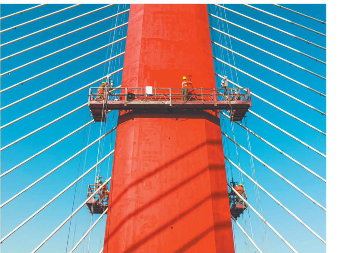
春节前夕,宿迁市对大运河宿迁大桥进行的装饰工程正在紧张施工之中,建设者们冒着严寒在对大桥进行漆面刷新,喜迎新年到来。 张连华 摄
