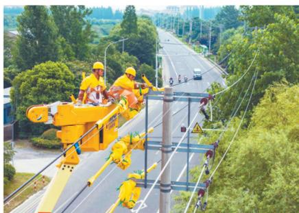
泰州供电公司带电作业人员全副武装，在海陵区对10千伏采陵线耐张线夹温度异常进行抢修作业。
