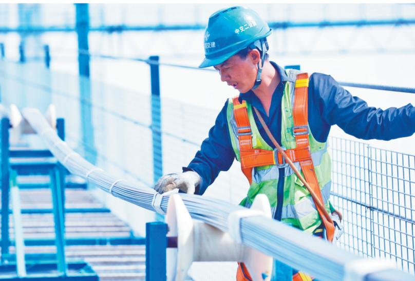
在龙潭长江大桥建设现场，工人们正在进行主缆架设施工作业。图为工人用缠包带绑紧主缆索股钢丝。
