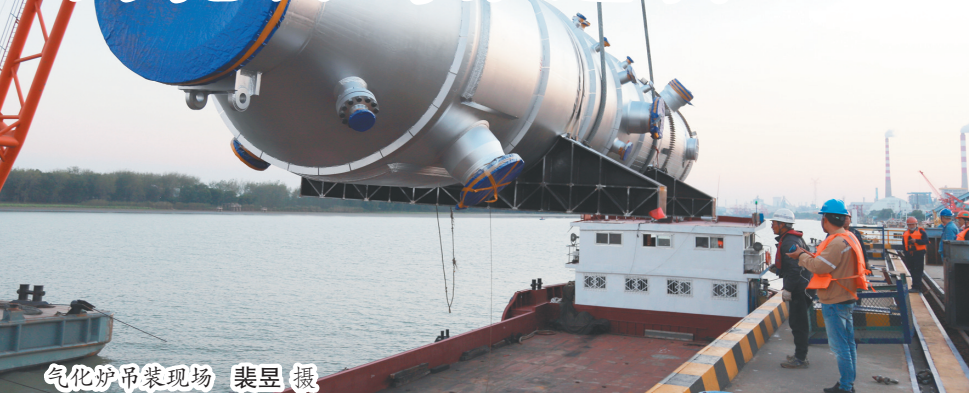
气化炉吊装现场 裴昱 摄
