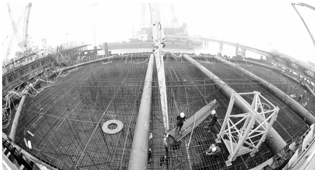
端午假期,国家重点工程——沪通长江公铁大桥建设工地一派繁忙景象,广大工程建设者放弃和家人团聚,坚守岗位,以确保工程进度按期完成。 庞瑞和 摄
