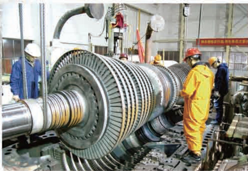
330MW六号机组大修环保技改
