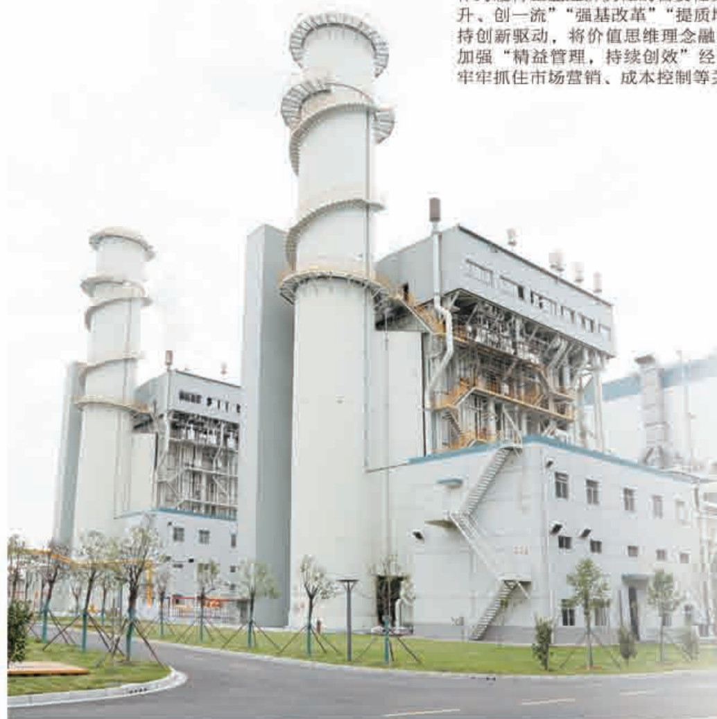
2台475MW天然气发电机组
