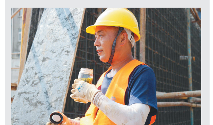
阳光很烈,劳动最美,致敬高温下的劳动者。近日,在中铁四局建筑公司南京王山头棚改PPP项目施工现场,工人李江国头顶烈日,在36度高温下坚守岗位、挥汗如雨,并利用片刻休息时间,喝茶解渴消暑。李大明 张飞
