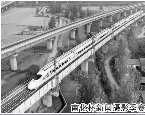
10月24日,青(青岛)盐(盐城)铁路连云港至盐城段按照正式运营程序和作业标准进行动车组列车试运行。试运行期间,各车站24小时安排车务、工务、供电、施工等相关应急值守人员,负责运行期间设备的临时维护和应急抢修,确保设备系统性能及状态达到开通运营要求。 王健民 任志平 摄
