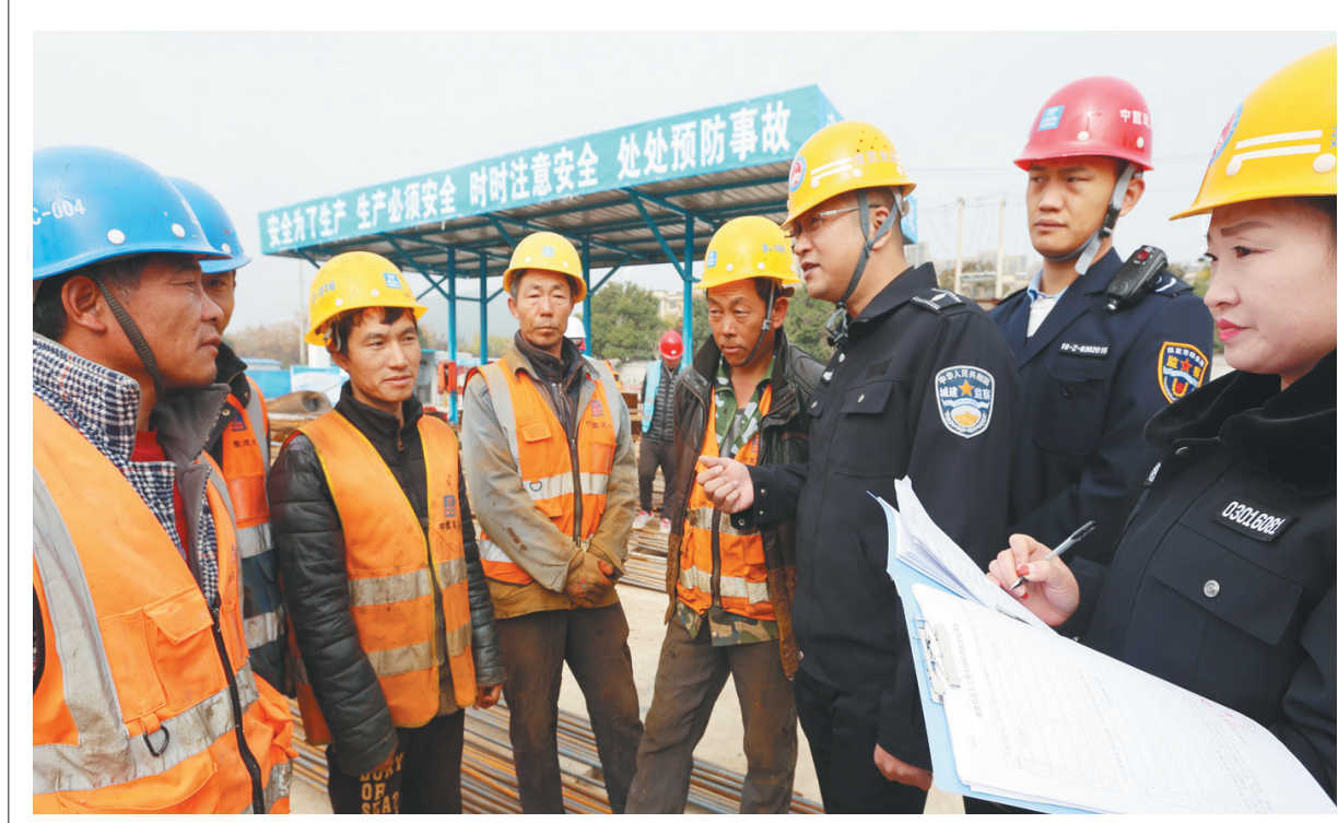
连日来，徐州市鼓楼区组织开展农民工工资支付专项检查，检查是否实名制管理、是否建立农民工工资专用账户等落实情况，保障农民工合法取酬权益。图为人社局和住建局监察工作人员在建筑工地向农民工了解工资支付情况。 剧创 邵俊子 摄
