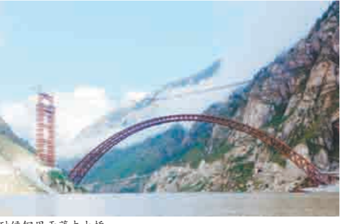
耐候钢用于藏木大桥
