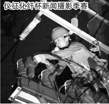
日前，台风“利奇马”过境，常州供电公司近300名抢修人员在风雨中当好市民安全用电的守护人，所有停电用户均很快恢复了供电。图为金坛区供电公司职工8月11日夜间在区中心10千伏市场线55#杆虹桥花园抢修电缆。
