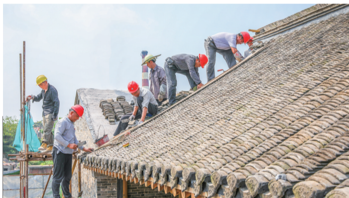
今年,我区启动上河边古民居保护工程项目,整合上河边四处主要的明清及民国时期古建筑,助推我区城镇经济和文化旅游发展。该工程占地面积为3105平方米,建筑面积为1325平方米。图为新安会馆施工现场。 颜禹铭 摄
