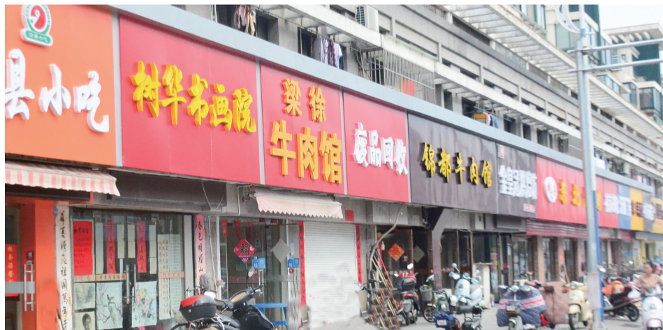
马厂路、三水大道(部分)等4个路段立面改造工程已进入施工阶段。此次改造须拆除破旧广告9726平方米，新建面板5700平方米，截至目前已完成60%的拆除和40%的新建任务。 陈宣 摄
