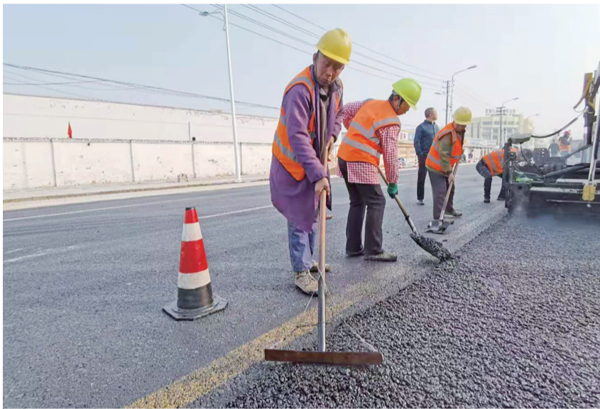
淮海路(三水大道-人民路段)道路改造项目EPC工程包含道路改造、雨水管道、污水管道、新建桥梁1座及沿线照明等交通设施,4月初开始施工,历经200多天,目前已进入扫尾阶段。改造后的淮海路由双向四车道变为双向六车道,将缓解交通压力。图为工人平整沥青。 黄文婧 摄
