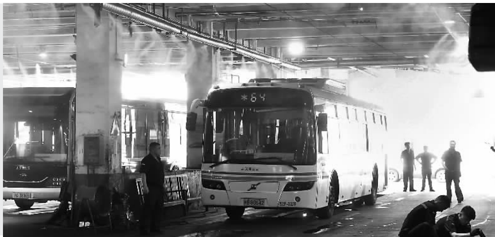
日前，巴士四公司重庆南路修理车间迎来了喷淋降温装置，这是今年久事集团工会实事工程之一。往年高温季，车间修理场内温度高达40-45℃，今年安装完喷淋降温装置后，真真切切地给职工送去了高温福利。
